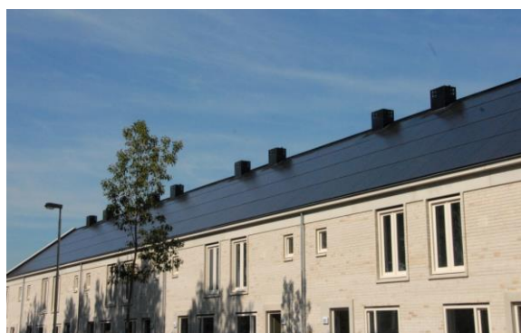
Figuur 4. Functioneel AERspire dak op de Karel de Grotelaan in Eindhoven.
